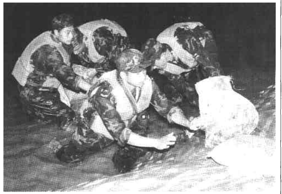
7月9日夜,南京军区某高炮旅战士在江苏盱眙县淮河支流团结河一处险堤下堵漏抢险。当日夜晚,江苏盱眙县淮河支流团结河堤出现管涌险情,南京军区某高炮旅紧急出动250名官兵投入抢险。
